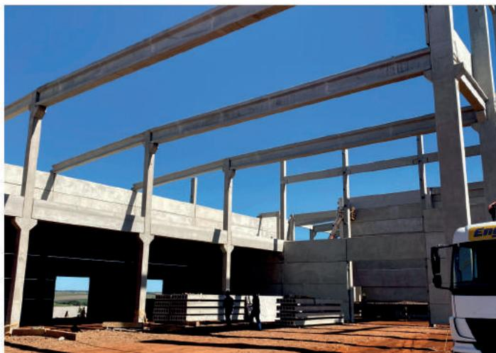
O uso de elementos protendidos em coberturas, permite vãos superiores a 26 metros em uma única peça, sendo bem maiores que no uso de concreto armado. Reduzindo a necessidade de pilares e diminuindo as dimensões dos elementos de concreto. Uma grande vantagem para prédios industriais e comerciais. Outro ponto favorável é a resistência da construção.
