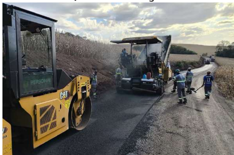
A obra compreende a execução de recape asfáltico em uma extensão de 3.600 metros
