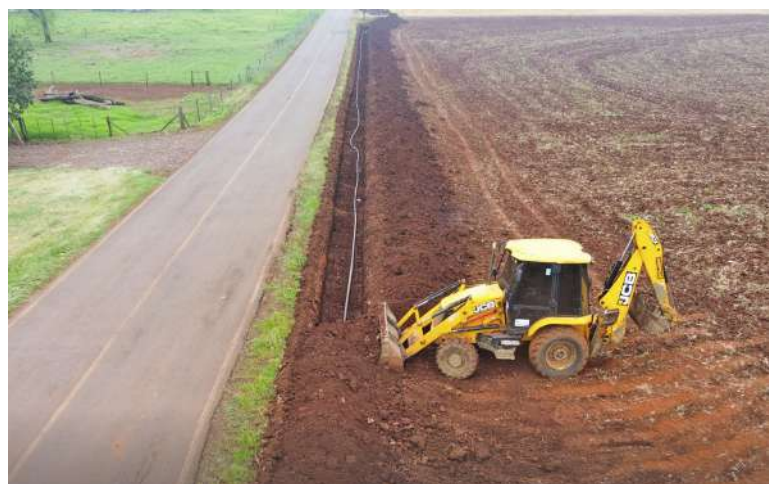
Essa obra é um passo importante na melhoria do abastecimento público de água
