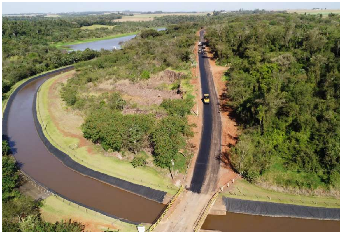
O trecho permanece interditado durante a execução dos serviços
