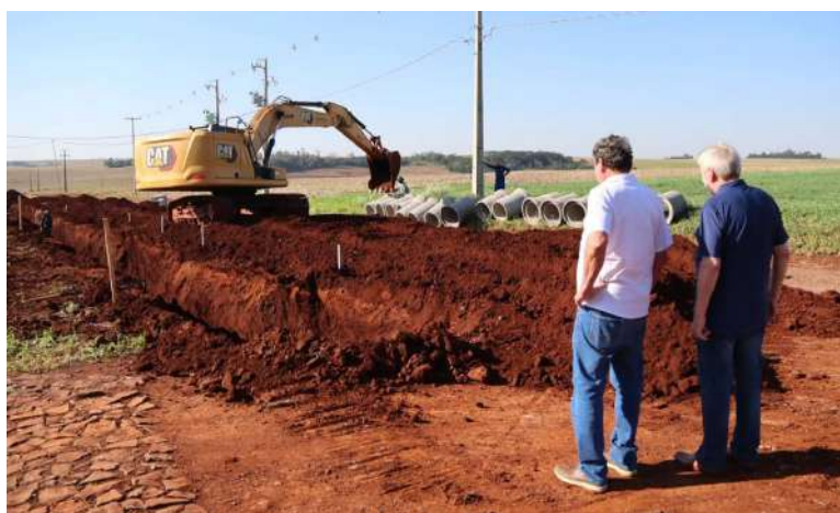
Com investimento de R$ 5.950.000,00, a obra representa um importante avanço na infraestrutura do interior
