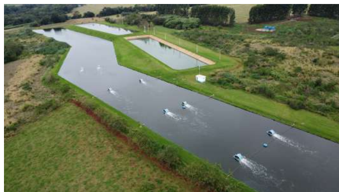
Estação de tratamento do esgoto, que também é responsabilidade do SAAE
