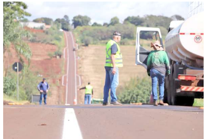
Para a execução dos serviços está sendo utilizado material termoplástico, considerado de alta durabilidade e resistência
