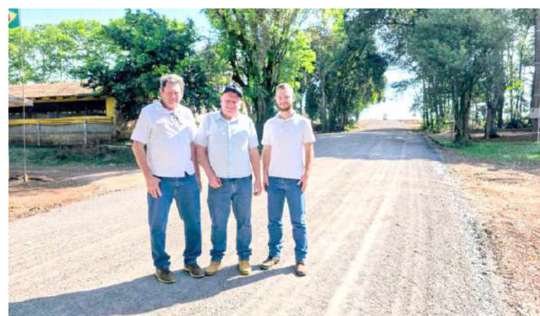
Entre Vila Cristal e Linha Dois Marcos as obras chegam a 700 metros
