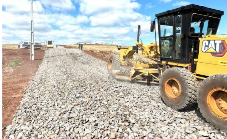
Com 60% da estrada já asfaltada, equipes agora preparam a base para a aplicação do asfalto quente no último trecho da obra
